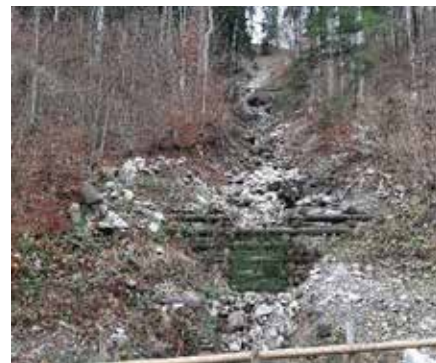
Seitengraben im Bereich Suegg (aktuell, vor Verbauung)
