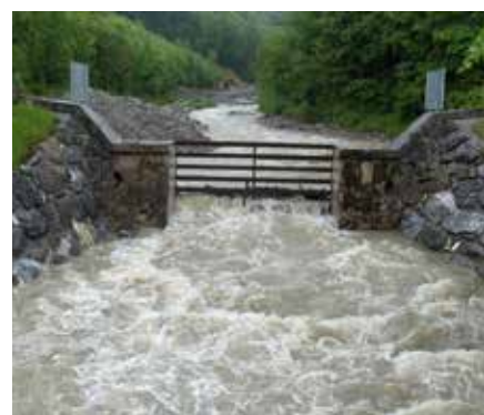
Umbau Sperre Mühltoibel (vorher/nachher) - Umbau zweit-letzter Sperre in Richtung Schönenbach in dieser Form
