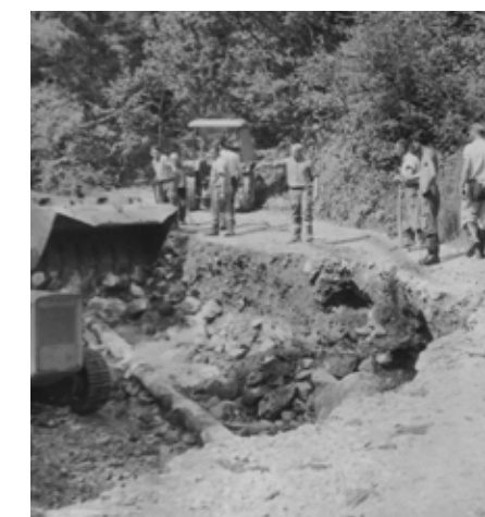
Die beiden obigen Bilder zeigen die Behebung von Hochwasserschäden im Bereich Löffelau im Jahre 1967 Bildquelle: Gendarmerieposten Bezau
