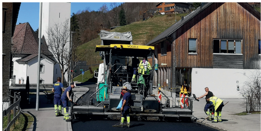
Straßensanierung L28 - Asphaltierung
