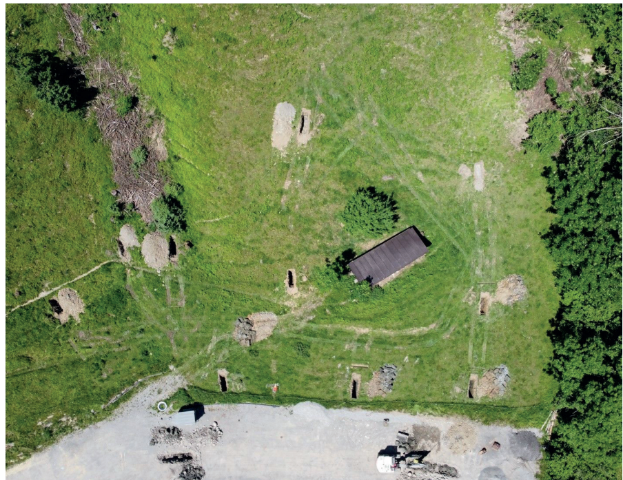
©geo zt gmbh Drohnenflug über die mögliche Bauparzelle während den Grabarbeiten der Sondierschlitz
